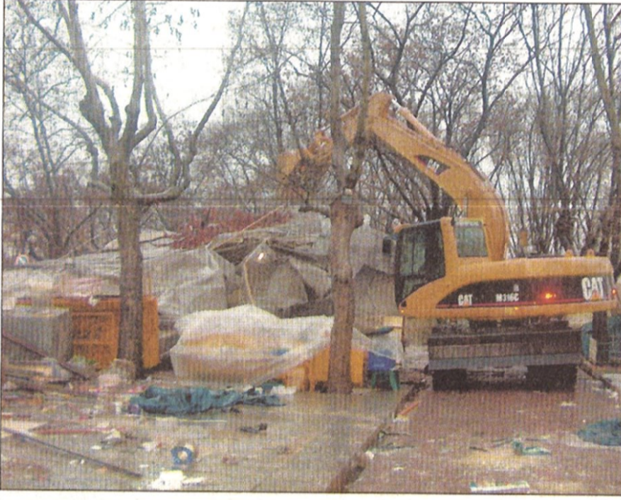
Yıkım, sabahın erken saatlerinde gerçekleştirildi...
